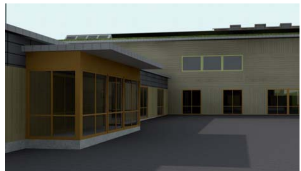
17. Exempel på exteriör förändring av de befintliga byggnaderna inom planområdet, gröna tak/solpaneler på hallen i norr och träfasad på kontorsbyggnaden på höjden (efem arkitekter 2012).
